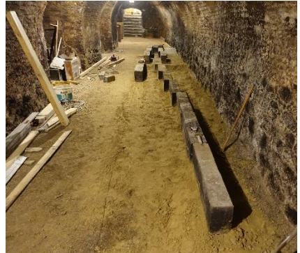
Verlegung der Fassaullager
